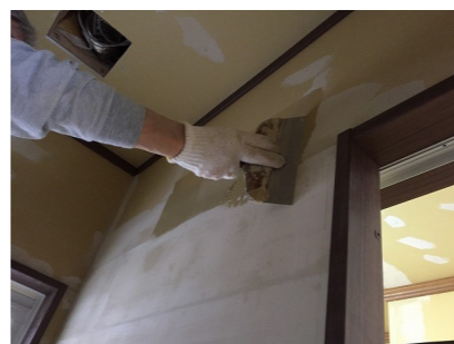
下地調整パテ処理状況
