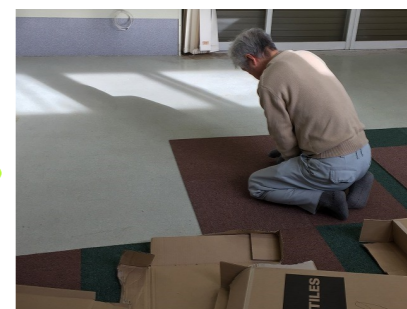
タイルカーペット敷状況
