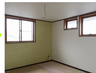
壁紙クロス張り完了
